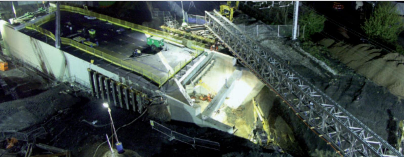
■ Mit 2 Metern pro Stunde wird der Kastentunnel an die richtige Stelle getrieben.
