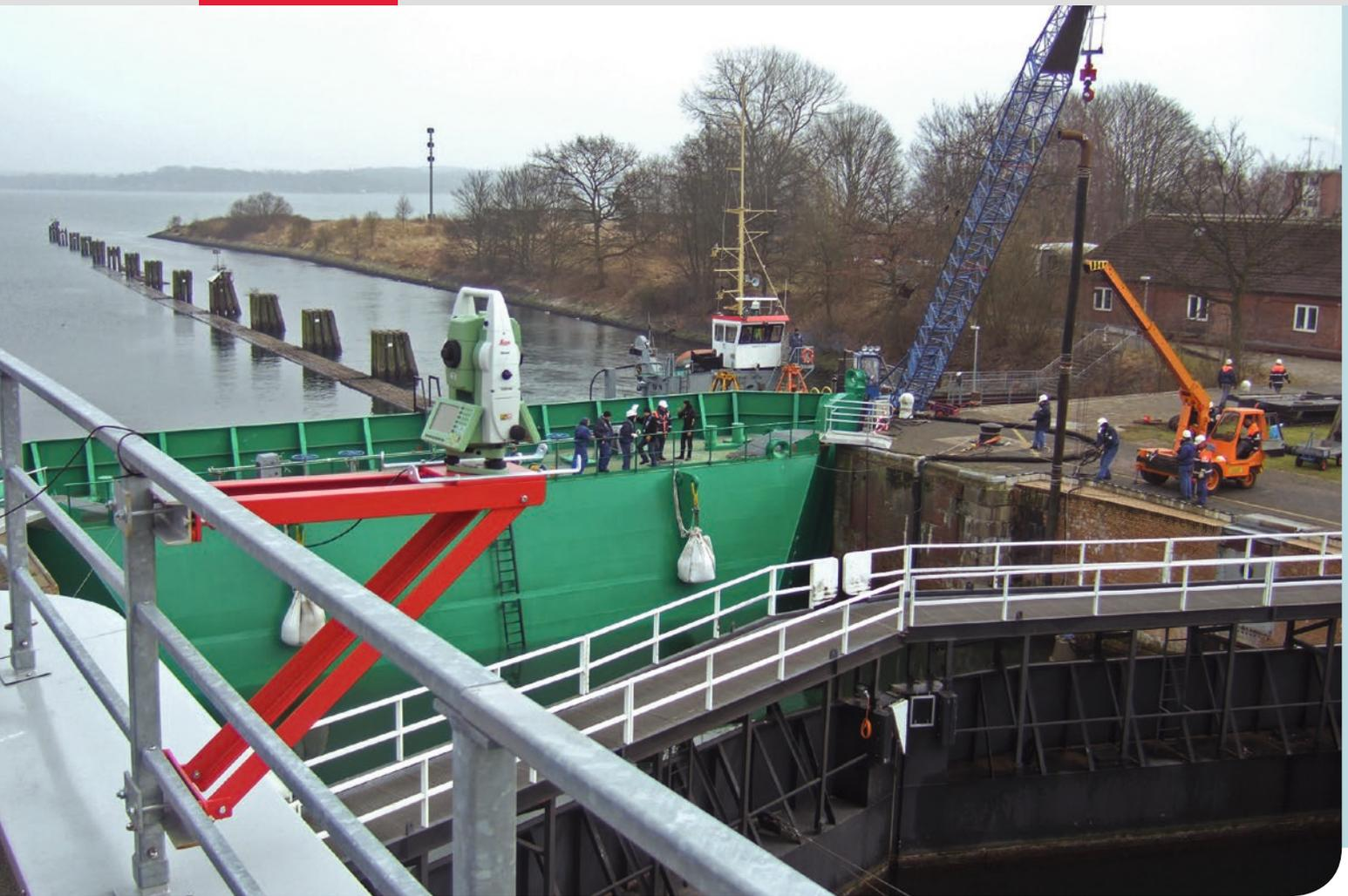
■ Eine Leica TCRP1201 Totalstation erfasst mögliche Bewegungen der Schleusenammer.
