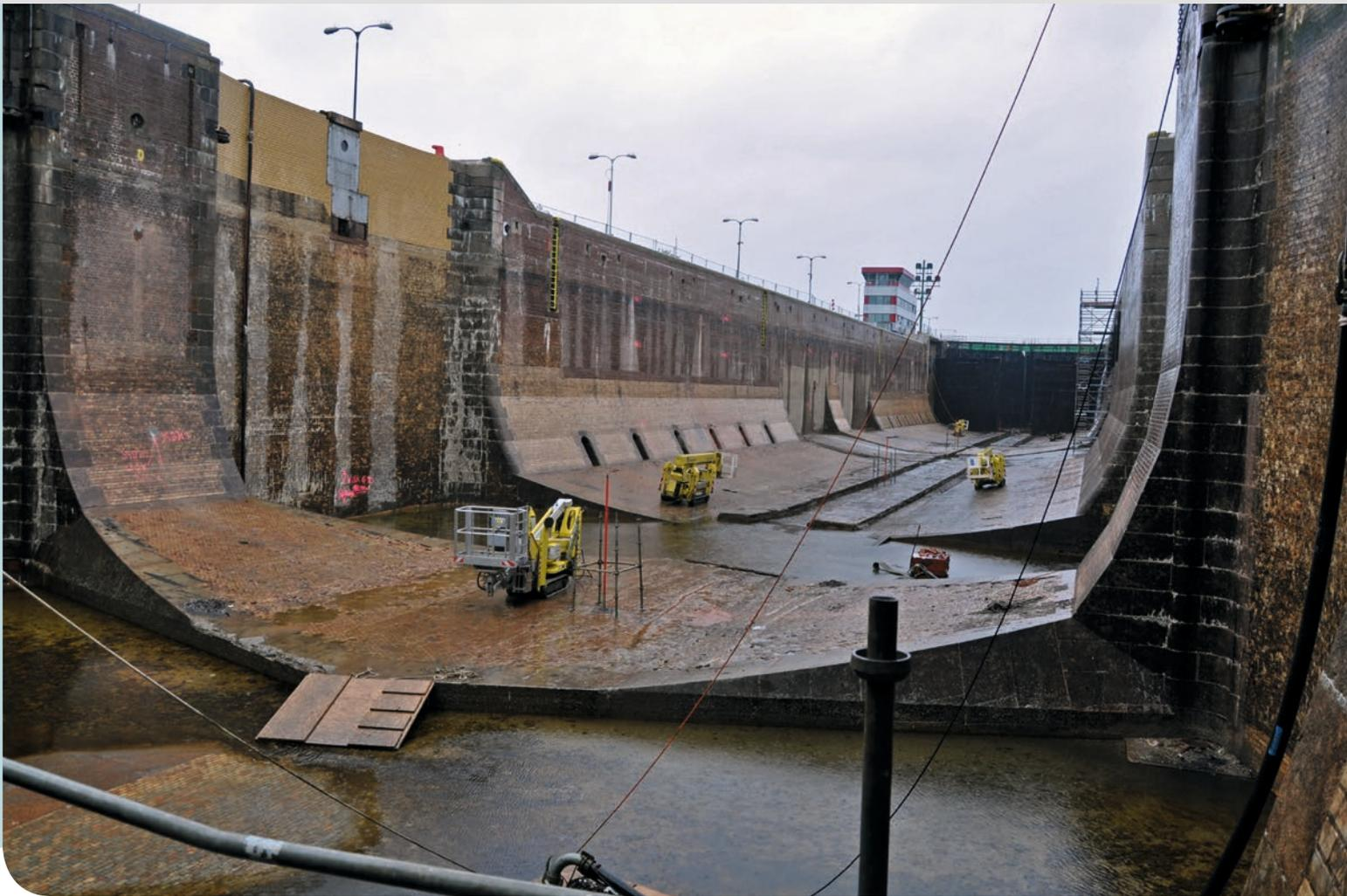
■ Bereit zum Renovieren: Die leergepumpte Schleuse wird inspiziert während die Kammern überwacht werden.
