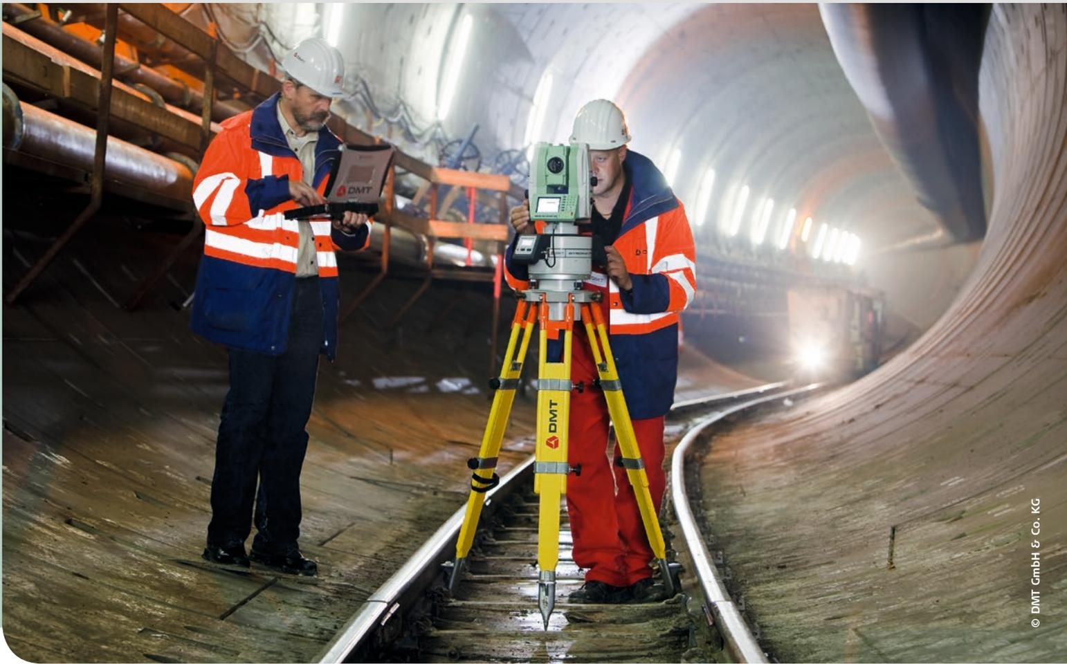
rées présentent une imprécision d'un millimètre, cette inexactitude se multiplie et aboutit à des écarts considérables dans l'axe transversal latéral des nombreuses courbures du tunnel et de sa direction.
