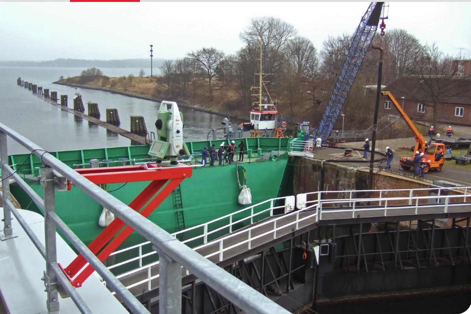
■ Une station totale Leica Geosystems prend des mesures pour surveiller les éventuels mouvements de la paroi de la chambre.
