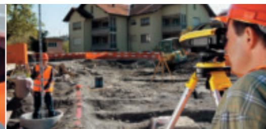
Contrôle d'altitude „tel que construit“, vérification de niveau, nivellement de surface, détermination de volume
