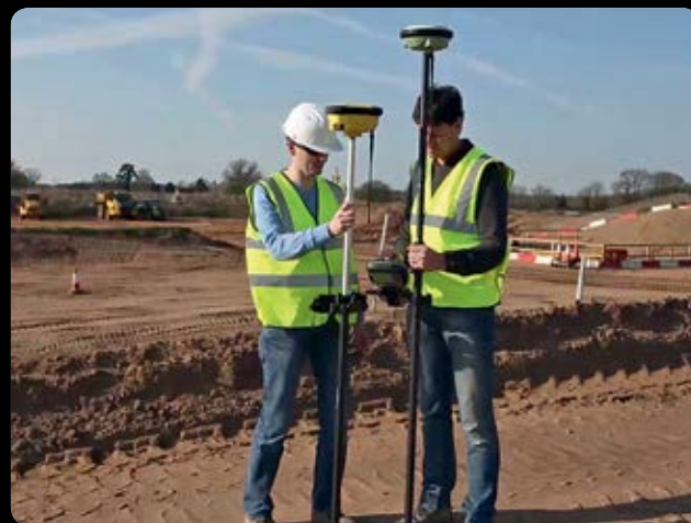
Vorarbeiter können Messdaten in iCON site zum Abstecken von Objekten vor Ort nutzen.
