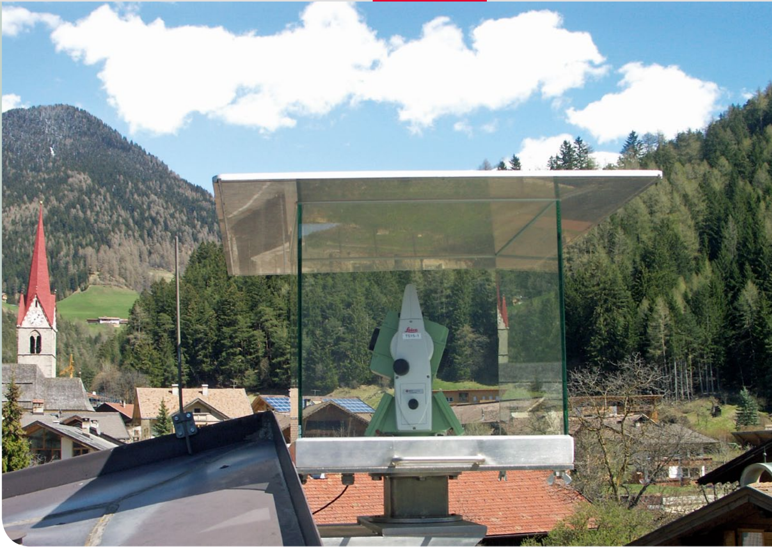
■ Eine Leica Viva TS15 Totalstation überwacht zusätzlich das Oberflächenverhalten in Mauls.
