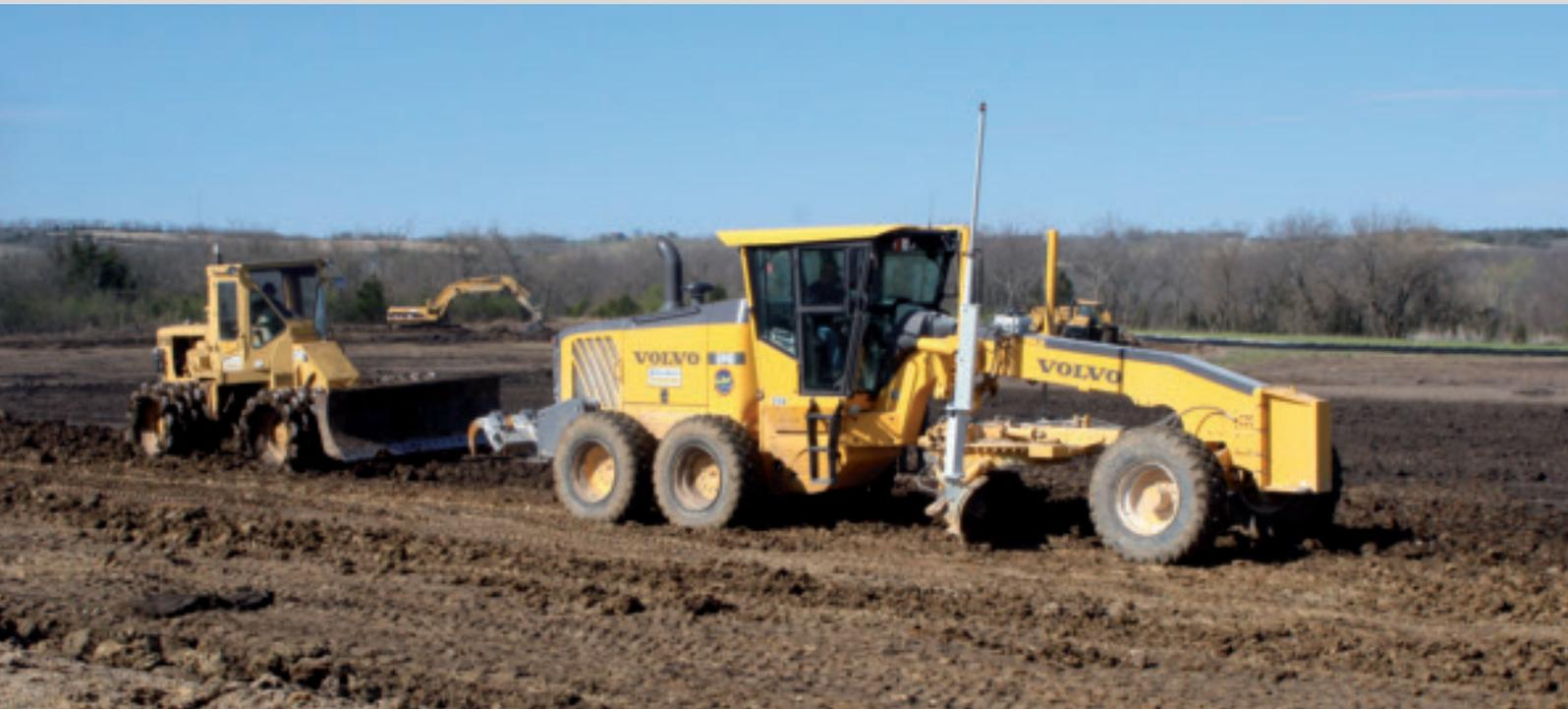
Geosystems ausgerüstete Raupe planierte das aufgefüllte Material mit einer Genauigkeit von  $\pm 3$  cm. Das GPS, so Schmidlein, ermögliche eine vertikale Genauigkeit von 2 cm, aber man wollte 3 cm Höhe für den Motorgrader lassen. Bob Parker ergänzt: «Das Leica GradeSmart 3D System zeigt dem Grader-Fahrer einen detaillierten Plan und die exakte horizontale und vertikale Position des Schilds.»
