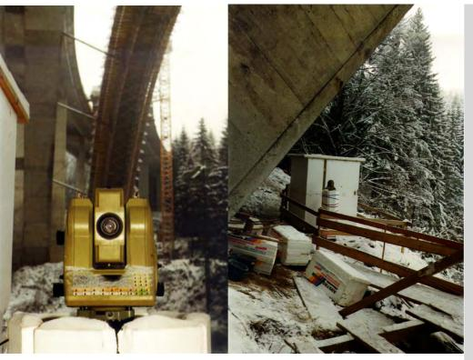
Für die Überwindung eines tiefen Taleinschnitts auf der Autobahn A2 im Packabschnitt<sup>\*</sup> wurde eine Bogenbrücke geplant. Die dafür notwendige Holzhilfskonstruktion wurde während des Betonierens permanent überwacht um die Menge des eingebrachten Betons regeln zu können.
