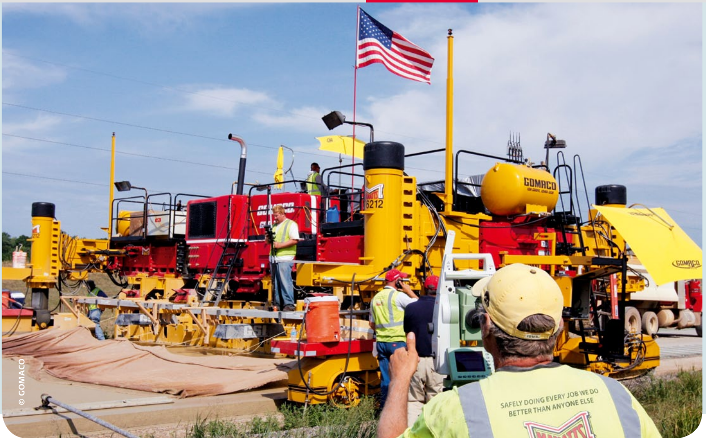
■ Ein Techniker überprüft die Höhe der neuen Betondecke mit einer Leica Geosystems Totalstation.
