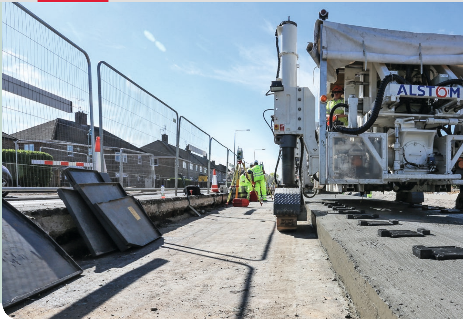
■ Gesteuert von Leica Viva TS15 Totalstationen und Pave Smart 3D, sorgt Appitrack™ von Alstom für ein sauberes Fundament für
