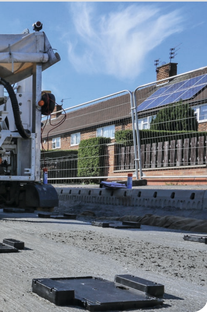
r die neue Trambahn.
