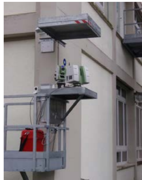
Figura 25: La stazione di montaggio per la verifica dello scanner esterno, con una Leica TS30. All'esterno i test di verifica della qualità vengono eseguiti con una stazione totale di rilevamento posta accanto al laser scanner e vengono misurati, a doppia faccia, le coordinate dei bersagli con entrambi gli strumenti nel più breve lasso di tempo possibile. Chiaramente gli obiettivi sono obiettivi particolari, con superfici dimensionalmente stabili e montate con entrambi i target che possono essere localizzati con precisione sia dallo scanner che dalla stazione totale.
